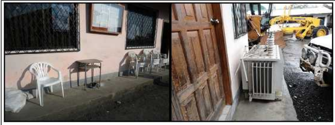
Figura 3.25: Corredor con Presencia de Escombros.
