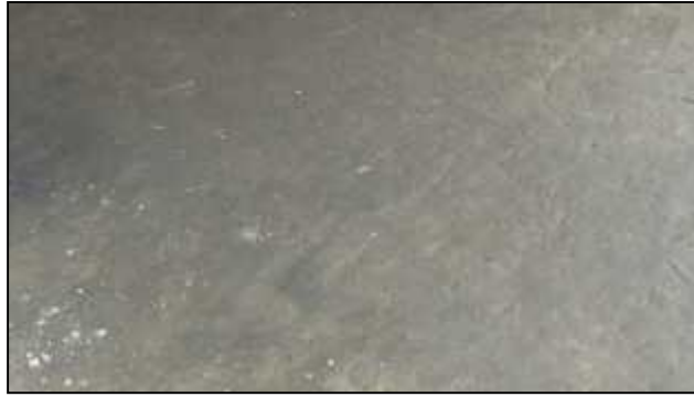
Figura 3.11: Suelo en Mal Estado.
