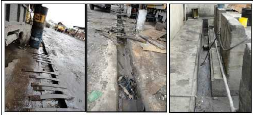
Figura 3.16: Drenajes en Mal Estado.
