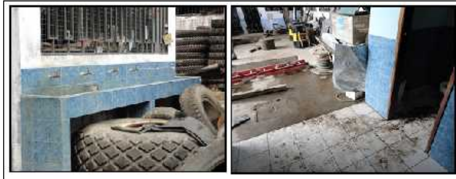
Figura 3.23: Servicios Básicos con Obstáculos y en Desaseo.
