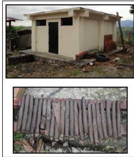
Figura 3.21: Depósito de Explosivos sin Señalización (TNT).
