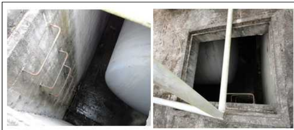
Figura 3.3: Espacio Confinado de Tipo Cerrado (Entrada al Depósito de Combustible).
