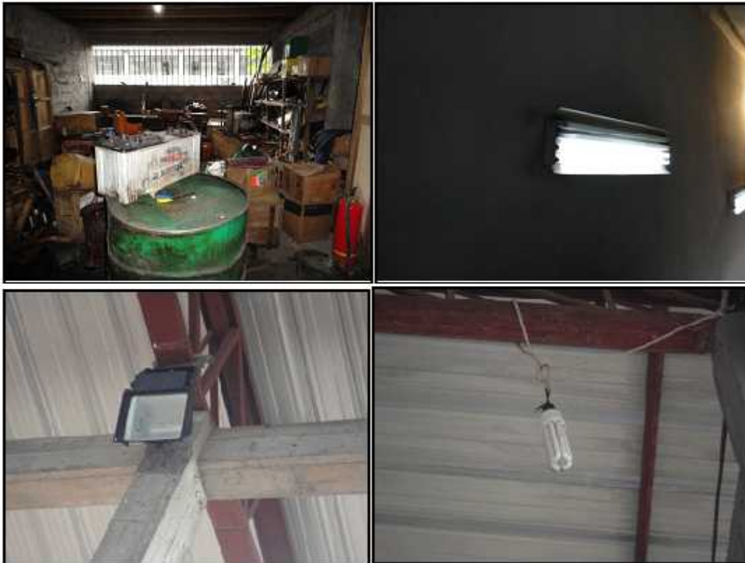
Figura 3.9: Zonas con Escasa Iluminación.
