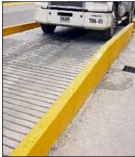
Figura 2.10: Rampa de Acceso de Vehículos.
