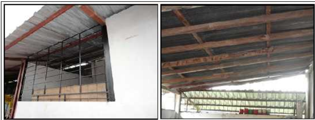
Figura 3.12: Techos y Ventanas Convencionales.
