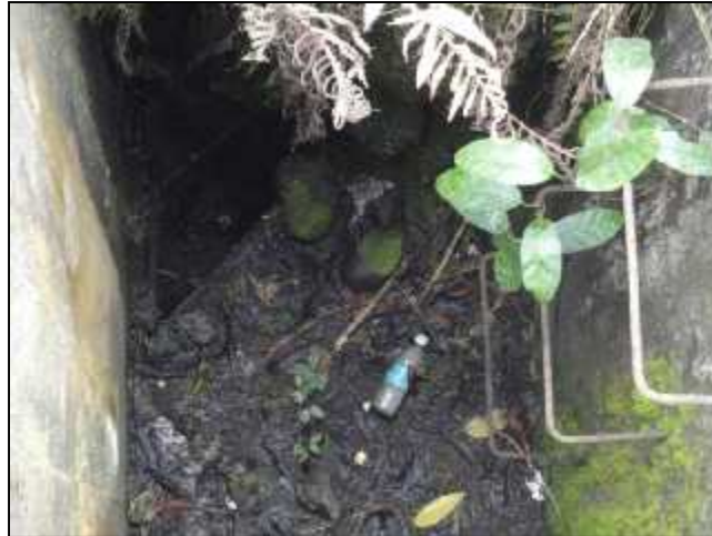
Figura 3.2: Espacio Confinado de Tipo Cerrado (Entrada al Depósito de Agua).
