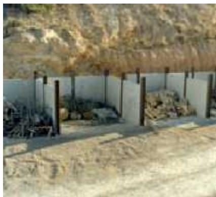
Figura 4.8: Celdas para la Separación de Residuos.
