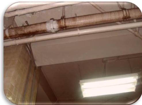
**Tuberías con Goteras**
