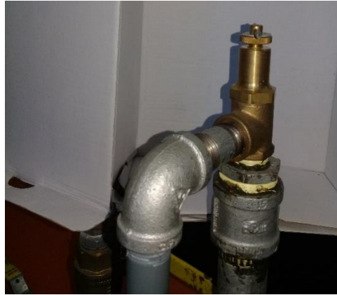
Figura 8-3: Accesorios en las tuberías Realizado por: Autor
