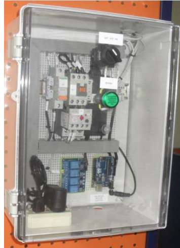
Figura 10-3: Tablero de control Realizado por: Autor
