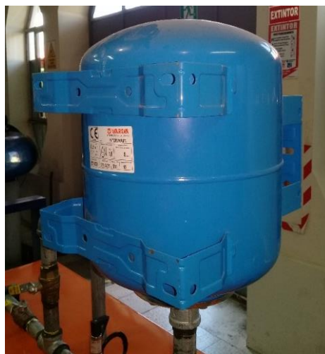
Figura 9-3: Calderín de aire Realizado por: Autor
