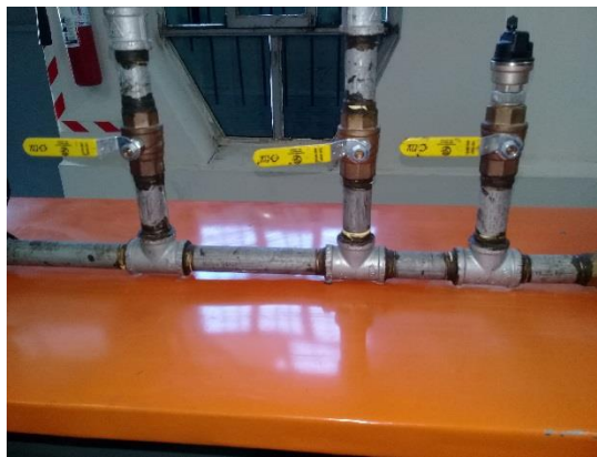
Figura 12-3: Tuberías Realizado por: Autor
