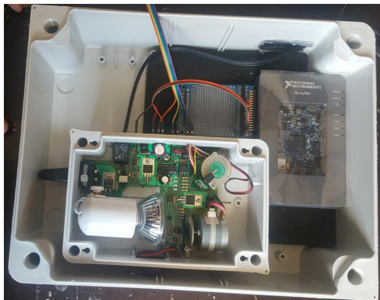
Figura 3-7 Montaje de los equipos en el tablero eléctrico de plástico Fuente: Autores, 2018
