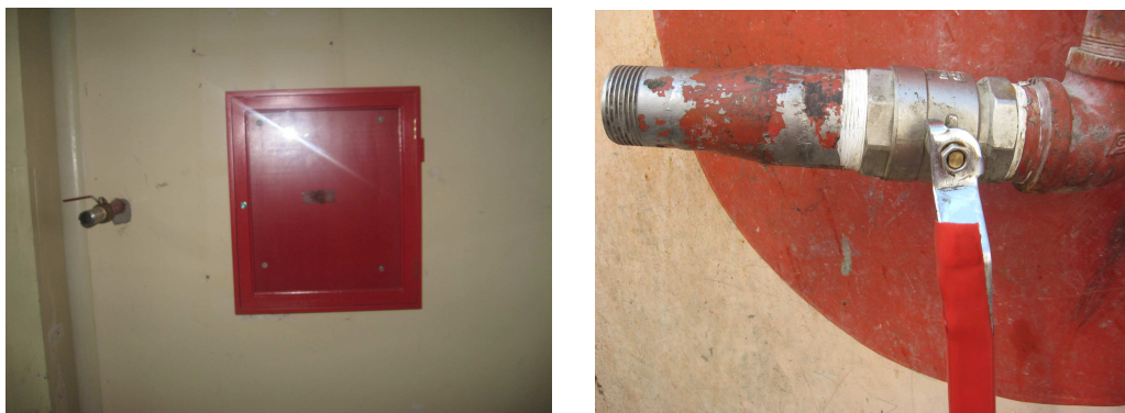
Figura 7: Cajetines sin mangueras, válvula en mal estado.
