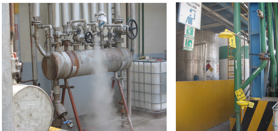
Figura 10: Condiciones de seguridad y señalización
