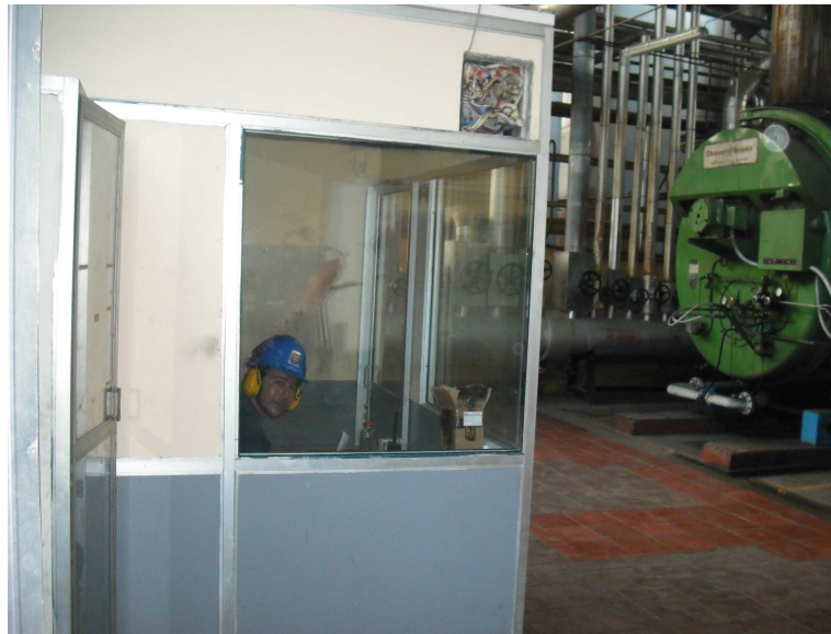
Figura 14: Cabinas para atenuar el ruido
