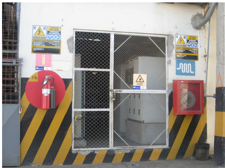
Figura 11: Condiciones de seguridad y señalización
