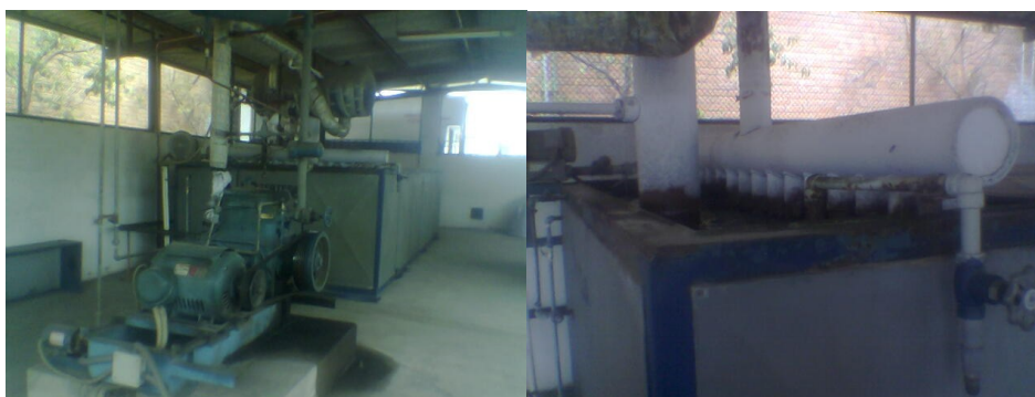
Figura 41. Sistema de generación de agua helada.
