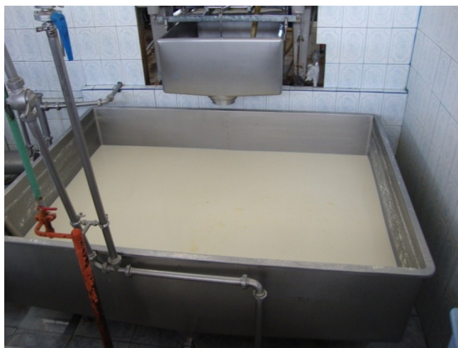
Figura 39. Tanque de recepción de leche.
