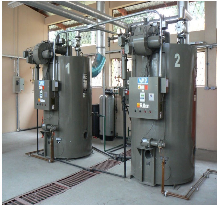
Figura 32. Caldera Piro tubular Vertical
