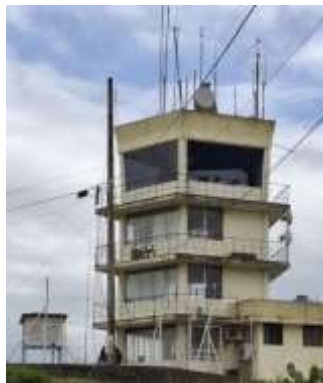
Ilustración 6: Torre de Control
